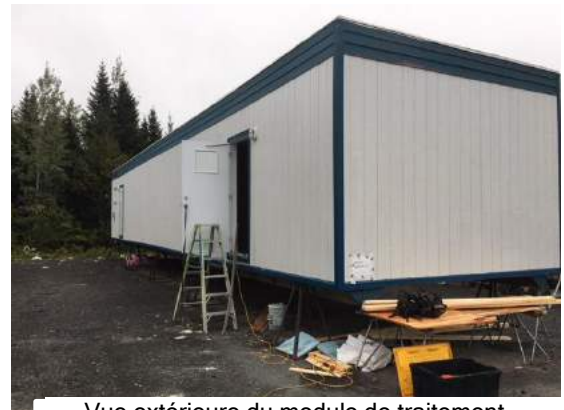
Vue extérieure du module de traitement
