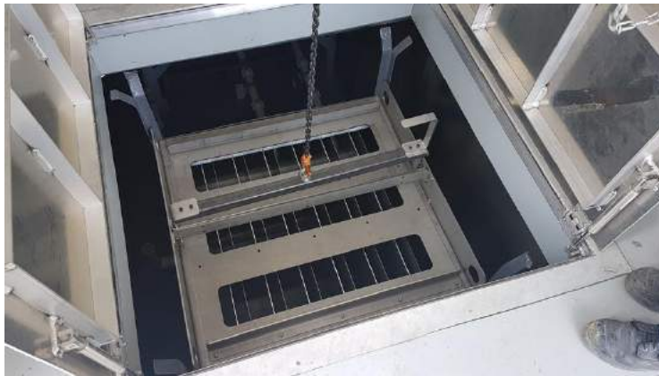
Vue du dessus d'une cassette d'électrodes
