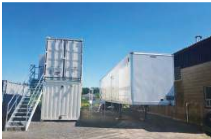
Pilote installé à la station d'épuration de la Ville de L'Assomption
